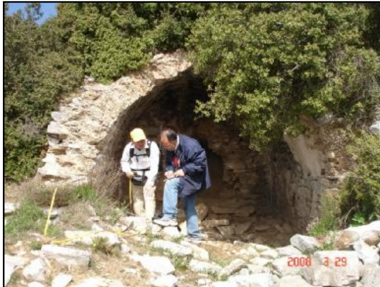
Αρ. 7: Αυτοψία και μέτρηση στην Ρωμαϊκή Κινστέρνα του λόφου Β'. δυστυχώς είναι κατεστραμμένη σε μεγάλο τμήμα της από την εγκατάλειψη αλλά και τους χρυσοθήρες.
