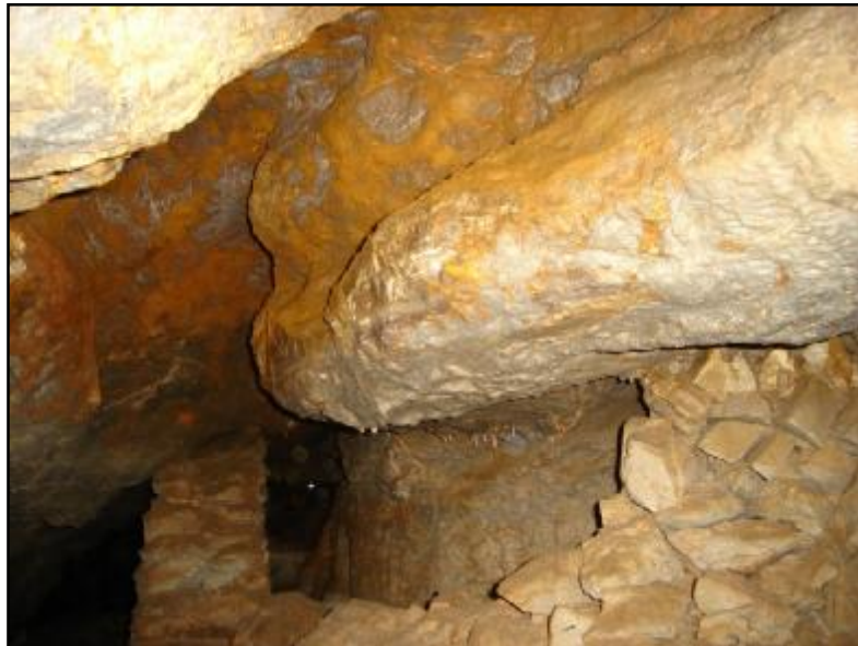
Αρ. 15 : Ορυχείο Π. Καβάλας. Υποστήριξη οροφής και ανθρώπινες επεμβάσεις.
