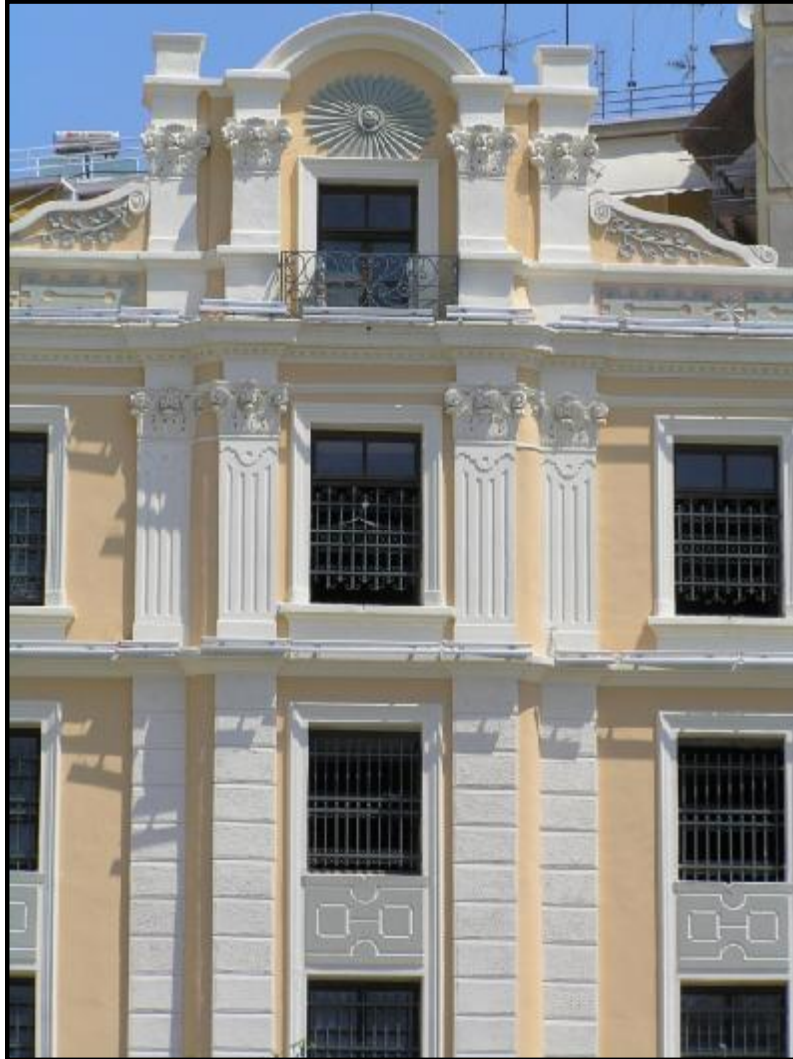
5. Κτήριο Καλναποθήκης. Λεπτομέρεια φωτιστικών στην πρόσοψη.
